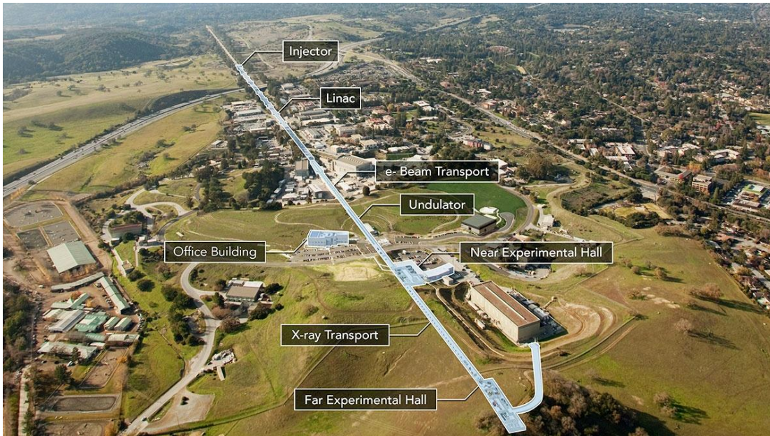
איור 3: X-Ray FEL הראשון בעולם (SLAC-LCLS). לזר בפעם הראשונה ב-10 אפריל 2009 בתחום אורכי גל 1.5-15 Angstrom. ה-FEL מבוסס על מאיץ LINAC בעל אנרגיית האצה 13.6 גיגה-וולט באורך קילומטר ו- wiggler (undulator) באורך 112 מ'.
